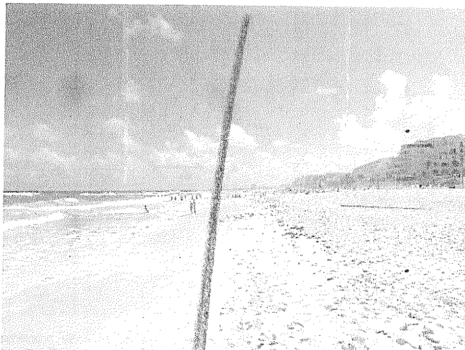
Foto 3. Resultado de la rehabilitación de la playa de frente al hotel. en la actualidad la playa se muestra con una gran cantidad de arena, tan es así que la distancia entre el muro de contención y el nivel máximo de pleamar oscila entre 29 y 36 metros. Como se muestra en la siguiente imagen la condición de la playa se ha mantenido estable en términos generales.
